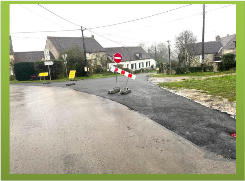
Réfection de la voirie
